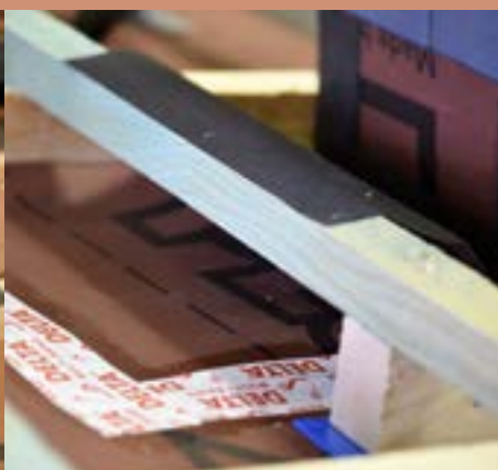
Vytvorenie odvodňovacieho žliabku
