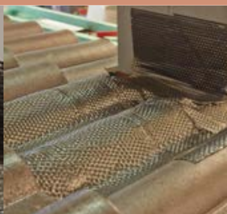
Dokončená zadná časť
